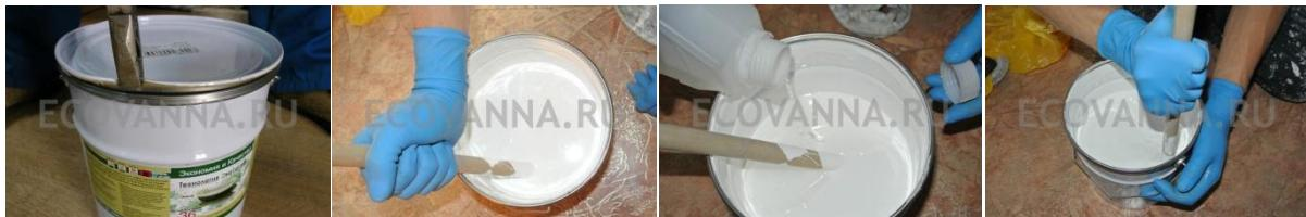
Перед смешиванием основы и отвердителя, перемешайте основу в течение 5 минут. Начинайте вливать отвердитель, продолжая перемешивание. После смешивания компонентов, продолжайте тщательное перемешивание в течение 10 минут. Не используйте для перешивания дрель - это вызовет излишнее попадание воздуха в материал. После перемешивания, дайте материалу настояться в течение 10-15 минут. В это время можно заняться подготовкой инструмента для налива и т.д.
