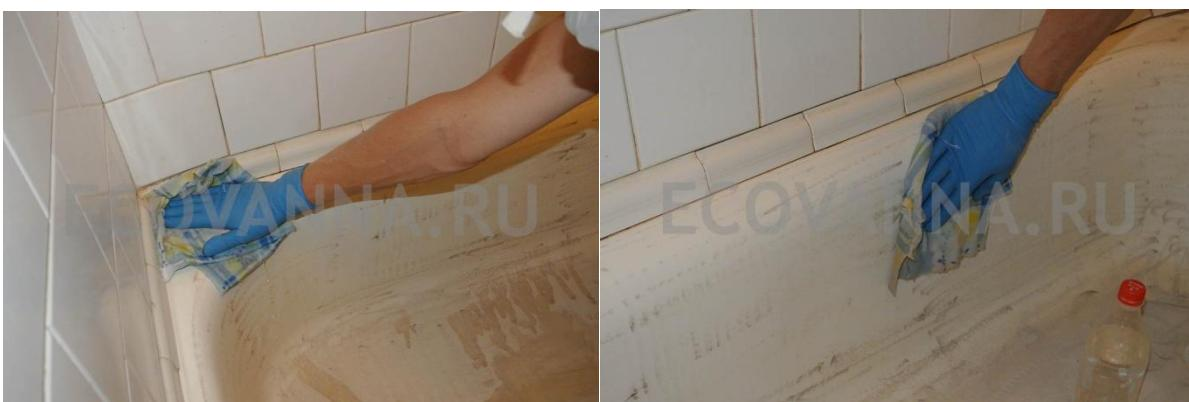
Для обезжикивания поверхности ванны используйте ацетон (Минимальный расход: 200 гр. на 1 стандартную ванну), нанесенный на тряпку (тряпка не должна ворситься). Повторите процедуру обезжикивания 3-4 раза подряд, разными тряпками. Альтернативный способ обезжикивания
